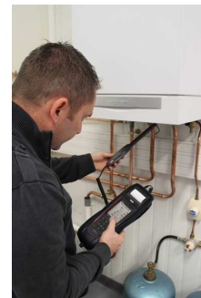
Vérification CO ambiant
